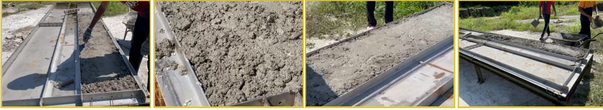
Penggunaan produk Flexi Steel Mould For Pre-Stressed Half Slab bagi menghasilkan half slab
