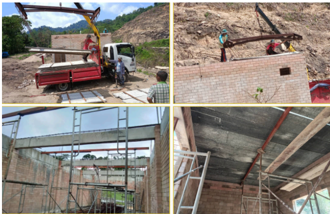
Penggunaan half slab dari produk inovasi “membina dan menyiapkan 1 unit rumah kediaman (batu) di atas lot 4192, Mukim Pak Pura, Bachok, Kelantan”
