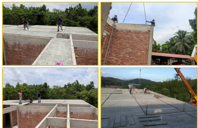
Penggunaan half slab dari produk inovasi “membina dan menyiapkan 1 unit rumah batu 2 tingkat di atas lot Pt1381 Mukim Kota, Jajahan Kota Bharu, Kelantan”
