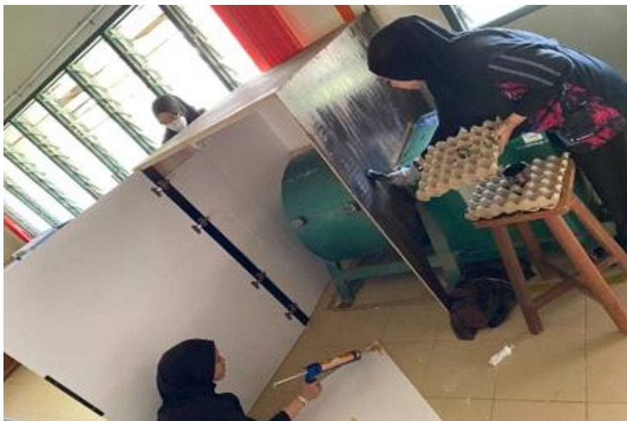
Rajah 6.1: Kerja-kerja menampal dinding SSI dengan gabus, sarang telur dan span.
