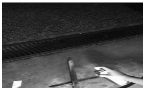
Rajah 11: Proses Mengecat Menggunakan Cat Semburan Tin Berwarna Hitam Untuk Mengelakkan Daripada Berkarat
