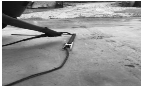
Rajah 10: Proses Kimpalan Bagi Tapak Untuk Pemijak Kaki Pada Tiang dan Tempat Untuk Meletakkan Kotak Eletrik
